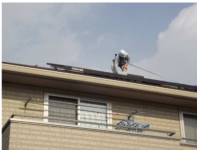
太陽光パネルの点検
